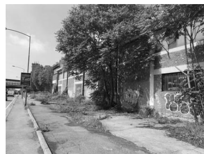
Area d'intervento (vista esterna)
