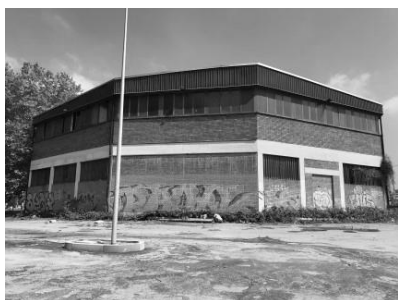
Area d'intervento (vista esterna)
