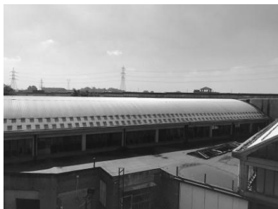
Area d'intervento (vista interna)
