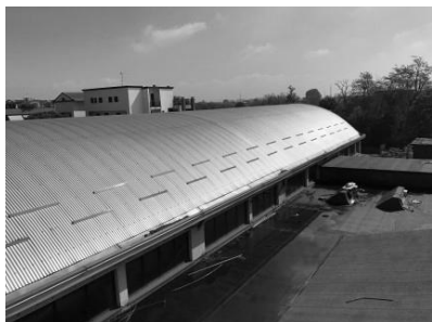
Area d'intervento (vista interna)
