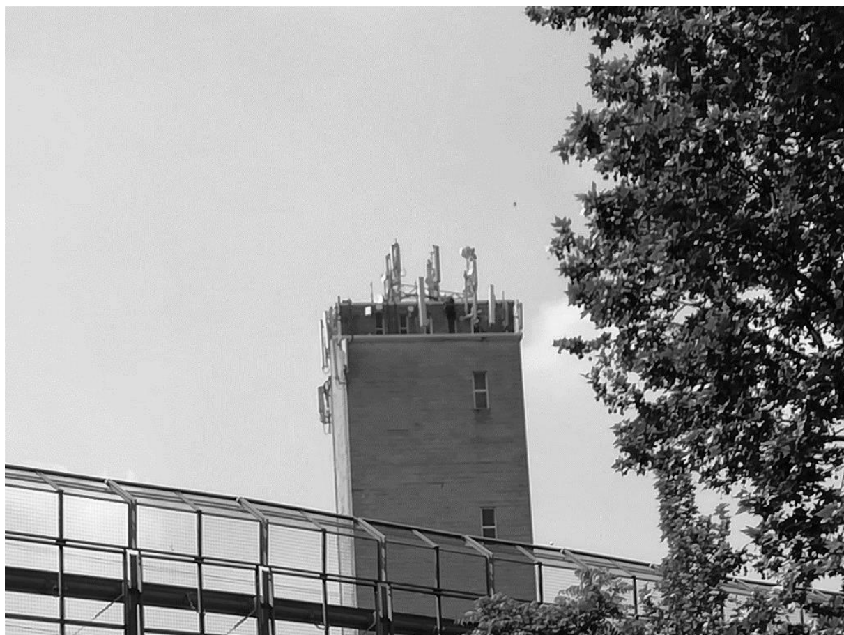
Torre dell'acquedotto con le antenne delle stazioni radio base dei 4 gestori di telefonia mobile
