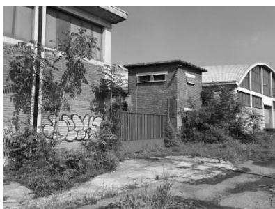
Area d'intervento (vista esterna)
