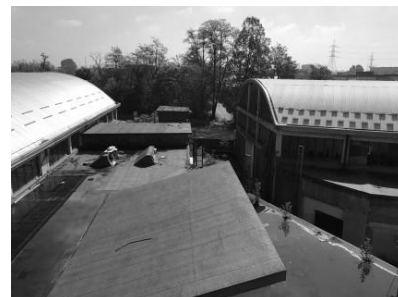
Area d'intervento (vista interna)
