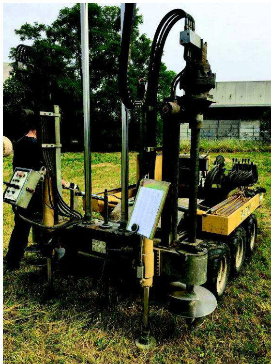
Esecuzione delle prove penetrometriche.
