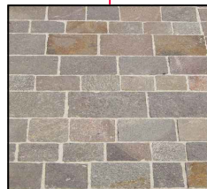
PAVIMENTAZIONE IN PORFIDO TIPO 2 • IN LASTRE RETTANGOLARI DI CRONATURA ROSSATA (dim. circa 20x20/20x40 cm)
